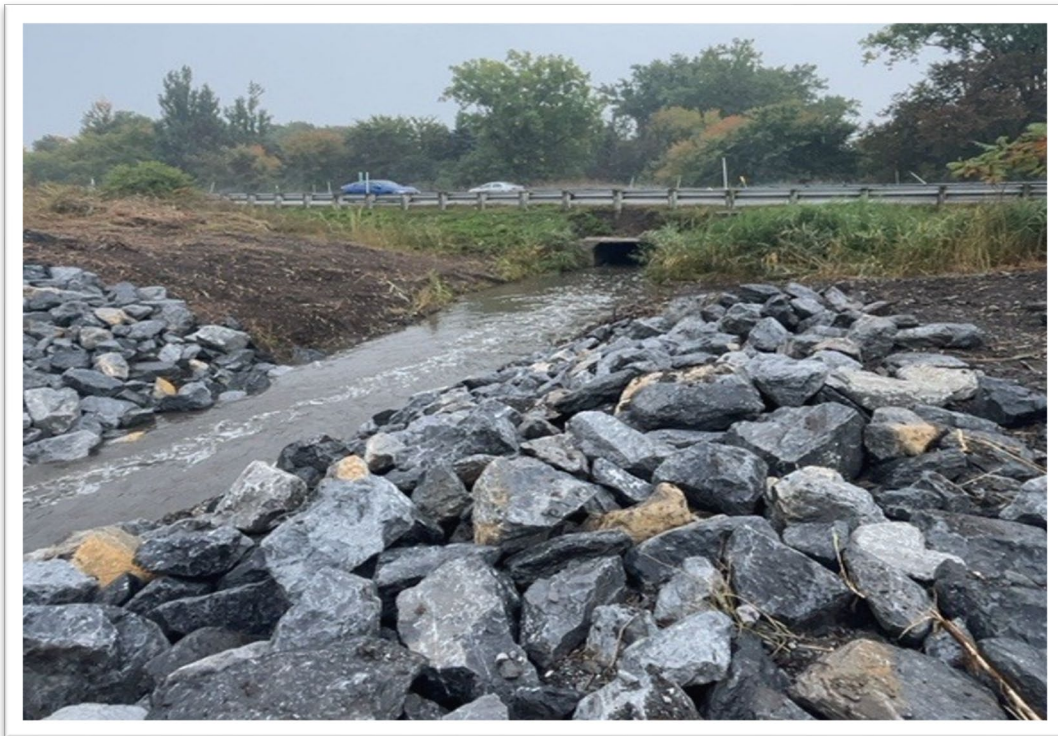
Figure 13: Retrait du chemin d'accès CN, vue vers le sud
