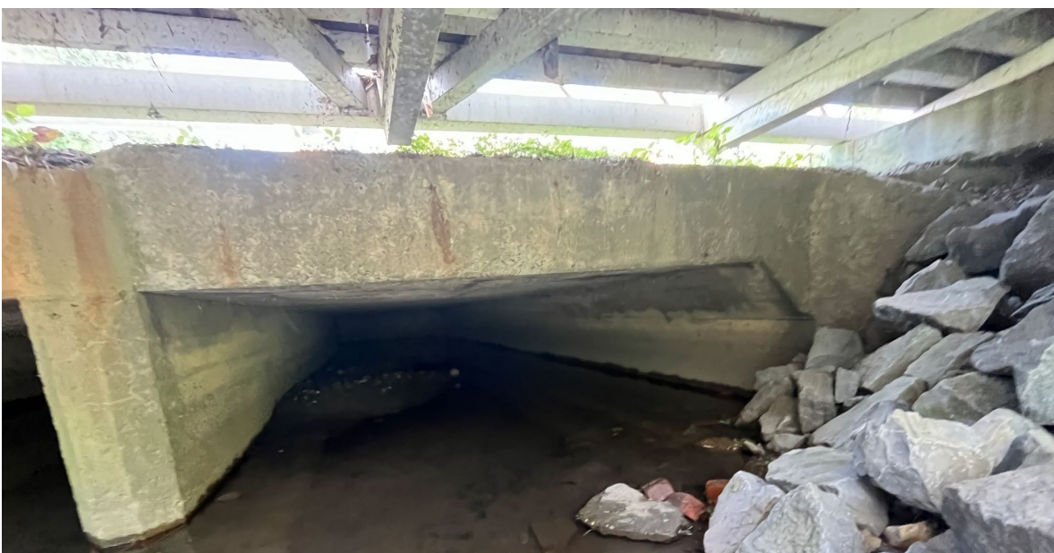
Figure 8: Ponceau près de l'intersection Elm et Tower, drainant les eaux du nord vers le sud
