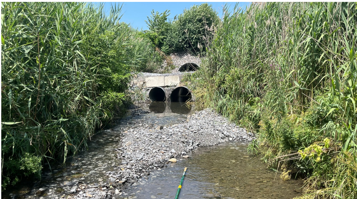
Figure 7: Deux ponceaux restrictifs installés par le CN entre 2019 et 2021
