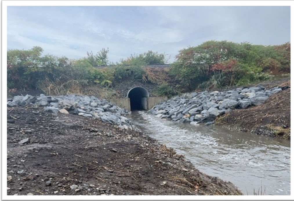
Figure 12: Retrait du chemin d'accès CN, vue vers le nord
