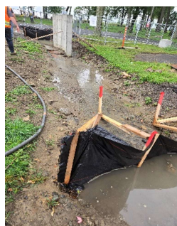
Mesures de gestion des sédiments mises en place sur le chantier (Sud)
