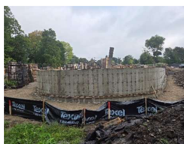
Mesures de gestion des sédiments mises en place sur le chantier (Sud)
