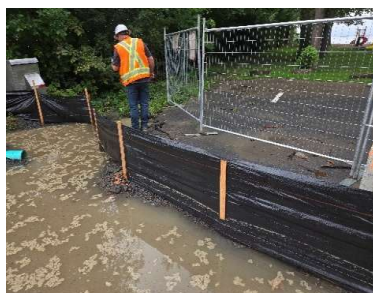
Mesures de gestion des sédiments mises en place sur le chantier (Sud)
